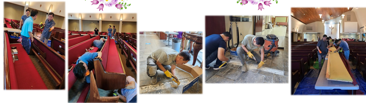
망치회 장래들 및 바닥 보수 공사
