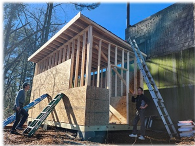
성당 외부 창고 공사
